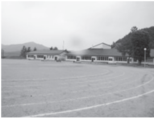
遠野市立土淵小学校校舎
