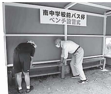
バス停小屋修繕の様子
